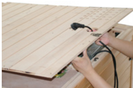
Obr.-22 Ved'te napájecí kabel skrz vnější horní panel
