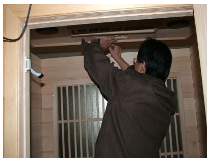
Obr.-13 Vedenie káblov ohrievačov na paneloch prostredníctvom príslušného
