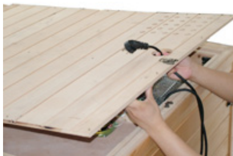
Obr.-22 Ved'te napájací kábel cez vonkajší horný panel
