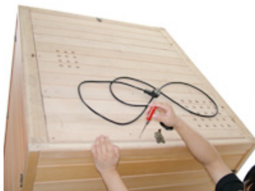
Obr.-23 Upevněte vnější horní kabel pomocí šroubů
